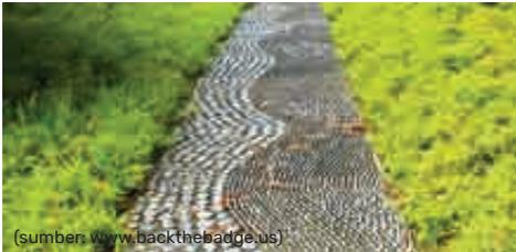
Ukuran jalur refleksi dapat dibuat menyesuaikan kebutuhan pengguna dengan lebar minimum 70 cm. Pola dapat dibuat bervariasi dengan susunan batu koral berukuran diameter 3-8 cm. Kemudian pada jalur refleksi diberi railing yang dapat terbuat dari stainless sebagai tiang pegangan dan disediakan bangku untuk tempat beristirahat.
