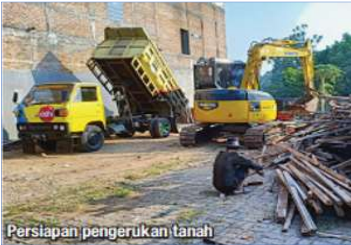
Pengerukan tanah untuk semi basment
