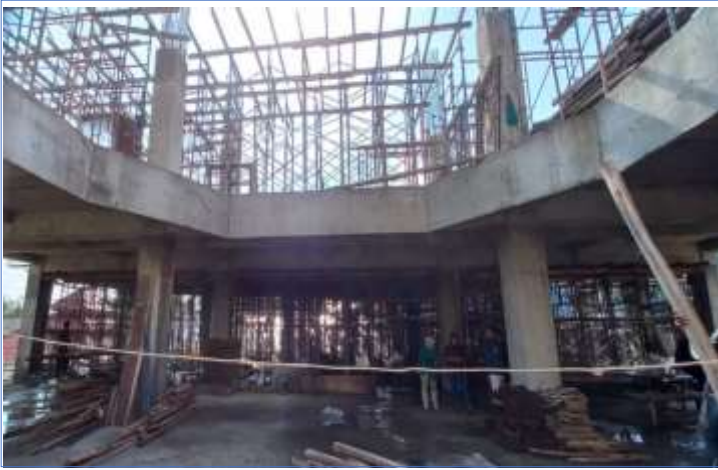
Pengerjaan pemasangan Bagesting
