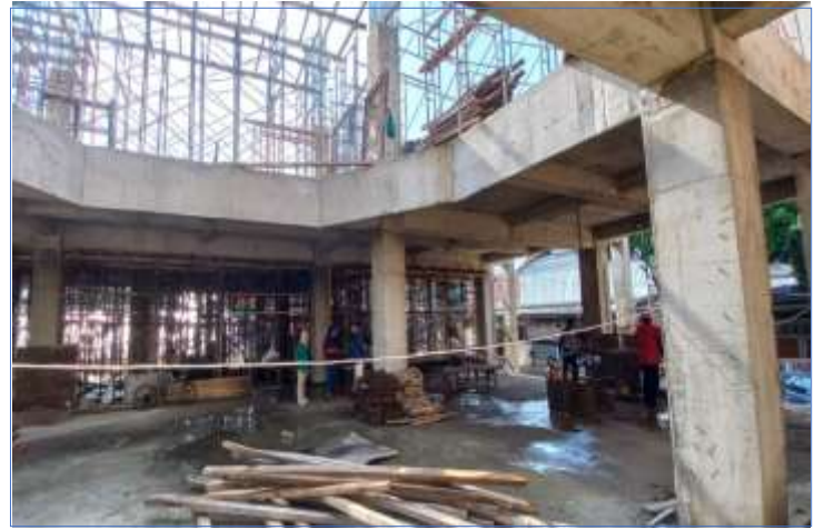
Pengerjaan pemasangan Bagesting
