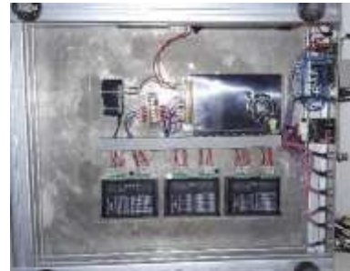
Gambar 4.2 Perakitan dan pengkabelan kontroler mesin
