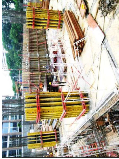
Gambar 11.A.5. Bekisting pra cetak (Sumber : sitrong Indonesia.com)
