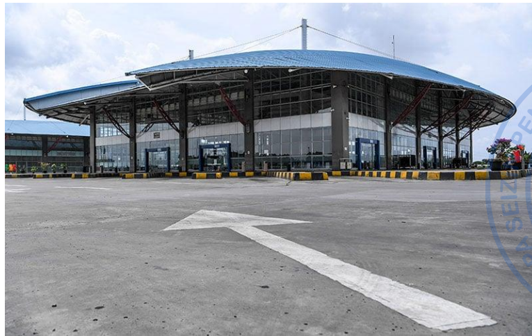
Gambar 1.4. Contoh Sistem Struktur Suspended (Terminal Pulogebang)
