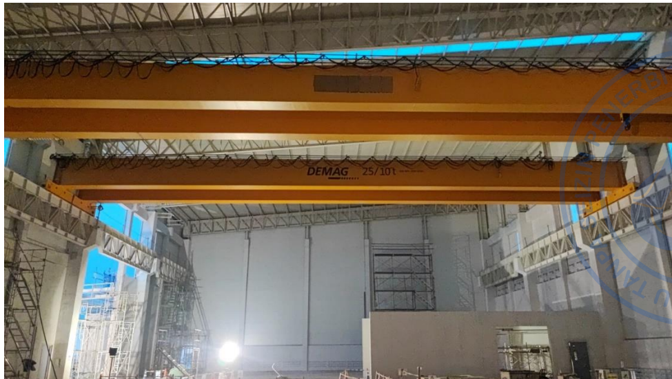
Gambar 1.1. Contoh Struktur Bangunan Industri dengan Crane (Sumber: Dokumentasi Pribadi)
