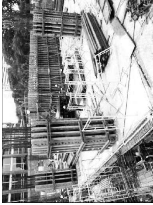
Gambar 11.A.5. Bekisting pra cetak (Sumber : strong Indonesia.com)
