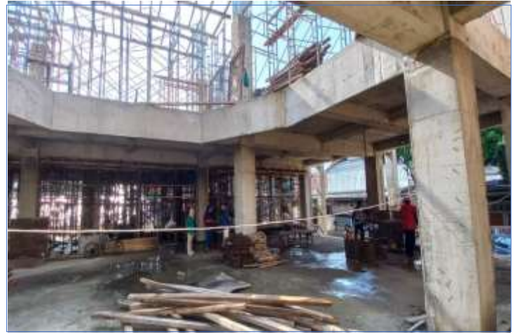
Pengerjaan pemasangan Bagesting
