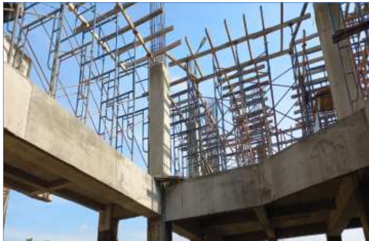
Pengerjaan pemasangan Bagesting untuk lantai 2
