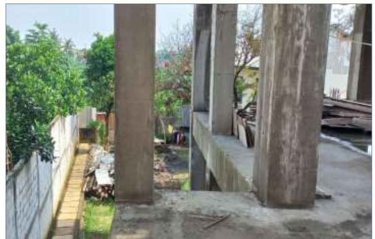
Pemasangan Bagesting untuk lantai 2 dan Tiang bangunan bagian sisi utara
