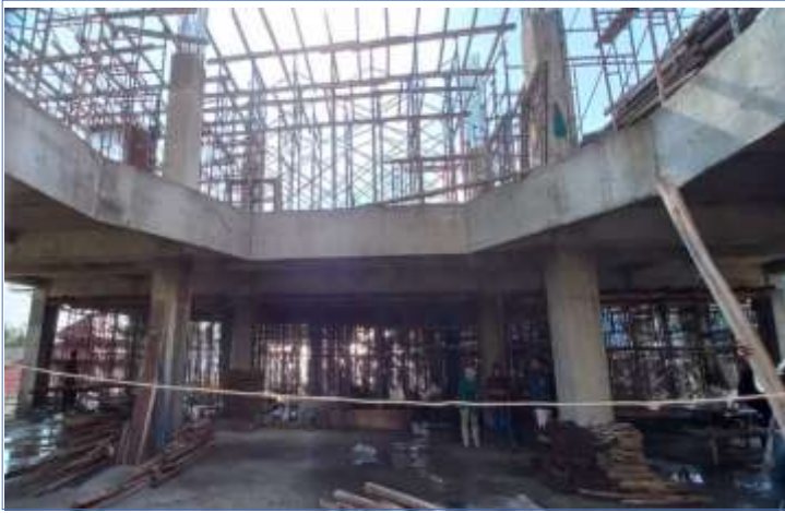
Pengerjaan pemasangan Bagesting
