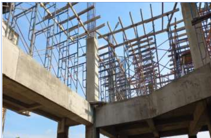
Pemasangan Bagesting untuk lantai 2 dan Tiang bangunan bagian sisi utara
