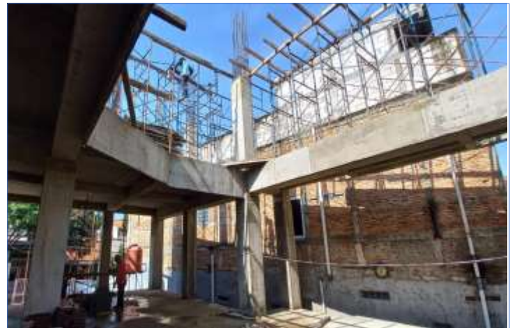
Pengerjaan pemasangan Bagesting untuk lantai 2
