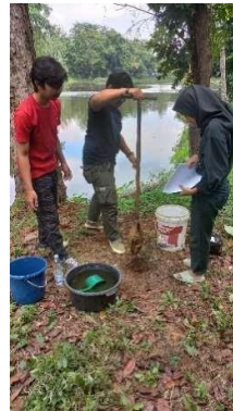
Gambar 7. 7. pembuatan lubang menggunakan bor biopori
