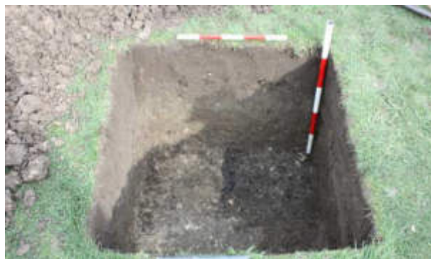
Gambar 2.4 Lubang Galian untuk Test Pit
