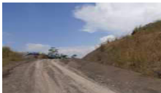
Gambar 4.6 Lokasi uji coba pada rencana jalan jalur puncak 2, di Hambalang, Sentul, Jawa Barat.
