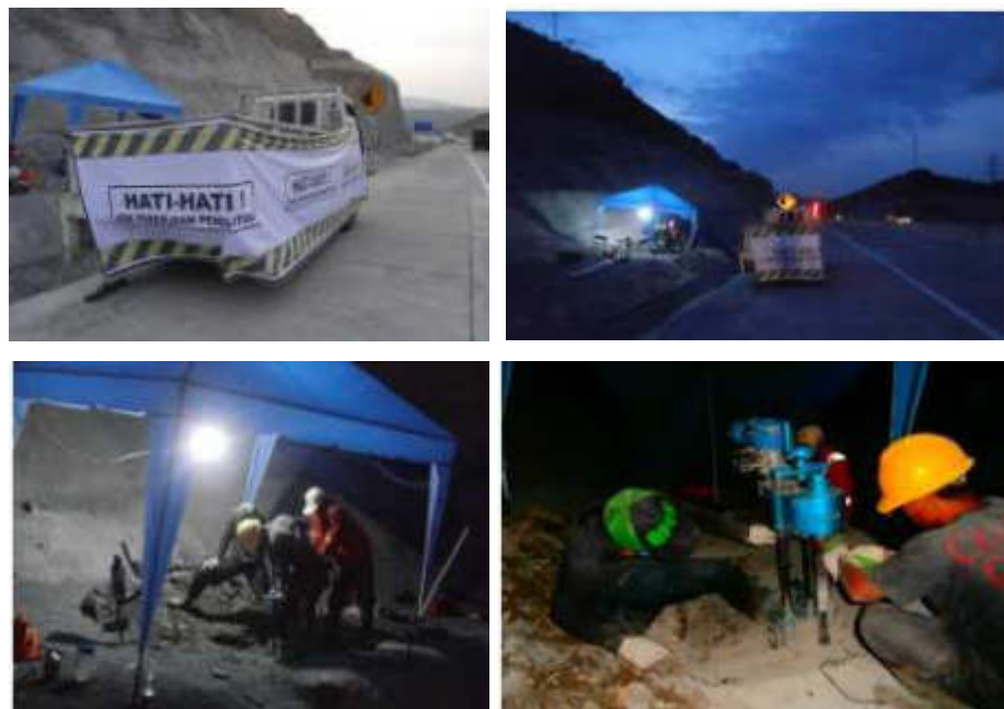
Gambar 4.13 Pekerjaan pengambilan sampel di Semarang Bawen dilakukan hingga larut malam untuk menghindari pelapukan pada lubang galian
