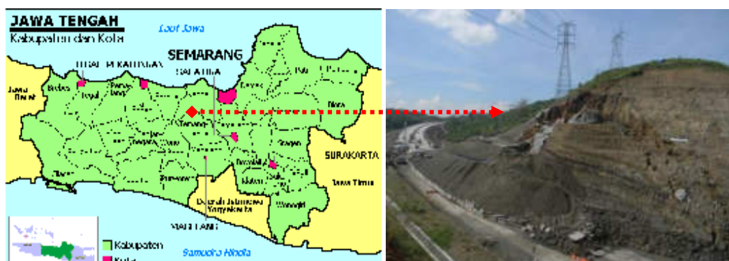
Gambar 1.6 Keruntuhan lereng clay shale di proyek jalan Tol Semarang Ungaran Bawen seksi STA 19+250 (Himawan, 2011)
