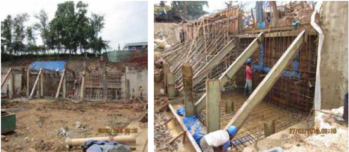
Gambar 4.19 foto proses pemancangan H-Beam sampai dapat dilakukan pemasangan DPT cantilever wall
