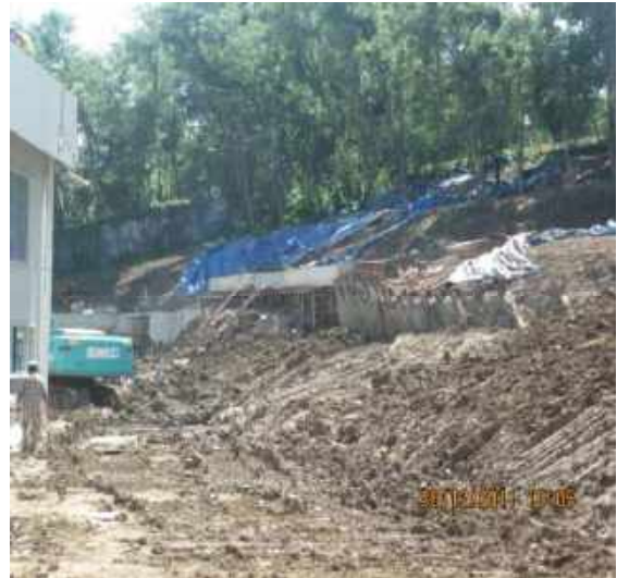
Gambar 4.15 foto psoses turap sheet pile selesai dipasang sampai terjadinya kemiringan turap sheet pile
