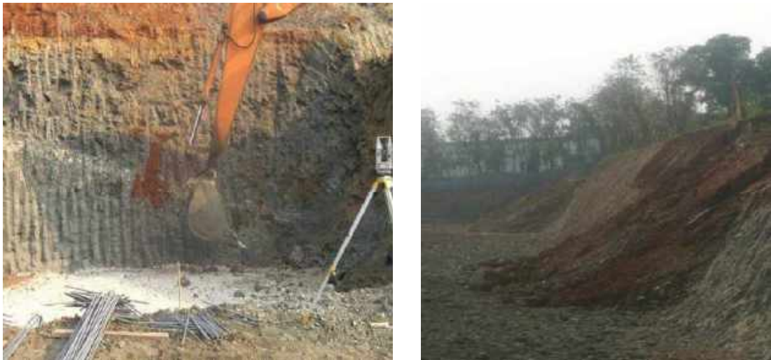
Gambar 4.11 foto psoses cutting tanah sampai kelongsoran tanah
