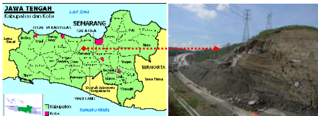
Gambar 1.4 Keruntuhan lereng clay shale di proyek jalan Tol Semarang Ungaran Bawen seksi STA 19+250 (Himawan, 2011)
