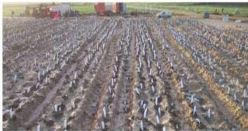
Gambar 2. 9 Vertikal Drain (Dr.Ir.H.Darwis, 2017)
